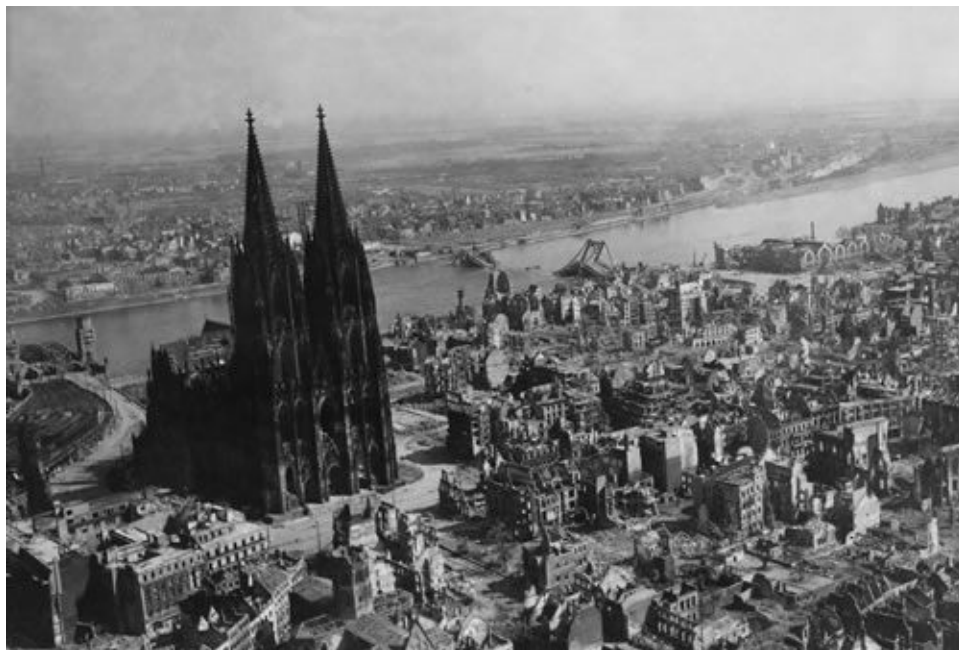
«En Colonia la vida ya no es posible», escribió un diarista alemán, y el poeta Stephen Spender comparó la derruida ciudad con «la boca abierta de un cadáver calcinado». A pesar de que los puentes del Rin y miles de edificios quedaron destruidos, la gran catedral sobrevivió.
